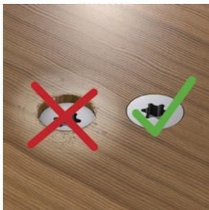
Poiché la testa della vite è a filo con il pavimento della terrazza, si evitano i cosiddetti "nidi d'acqua", che di solito finiscono per marcire.
